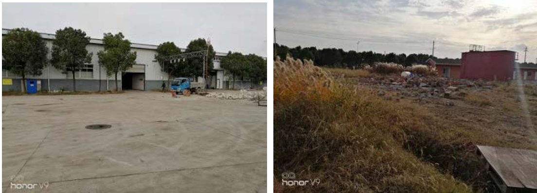
图 3.2-9 地块生产车间外部现状
