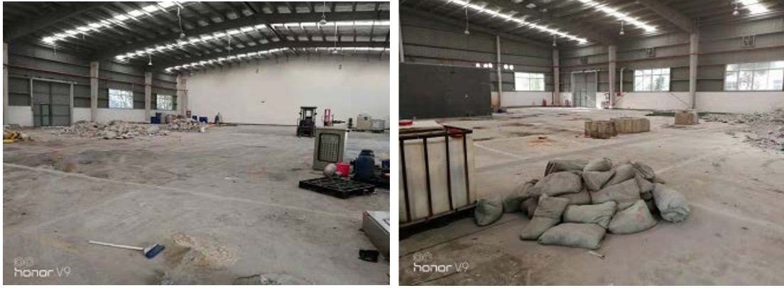
图 3.2-8 地块生产车间内部现状
